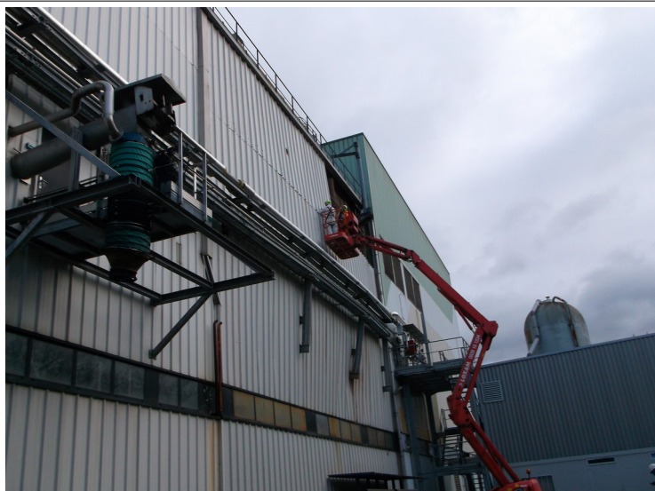
Photo du caisson de l'électrofiltre, qui a priori est intact la passerelle située à proximité a été déplacée par le souffle
