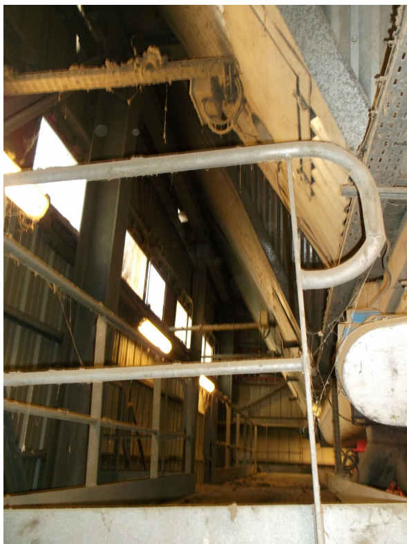
Photo du caisson de l'électrofiltre, qui a priori est intact la passerelle située à proximité a été déplacée par le souffle
